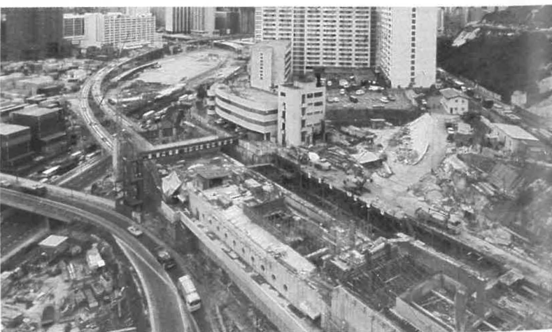
地鐵荃灣支線荔景車站的建築全貌。
