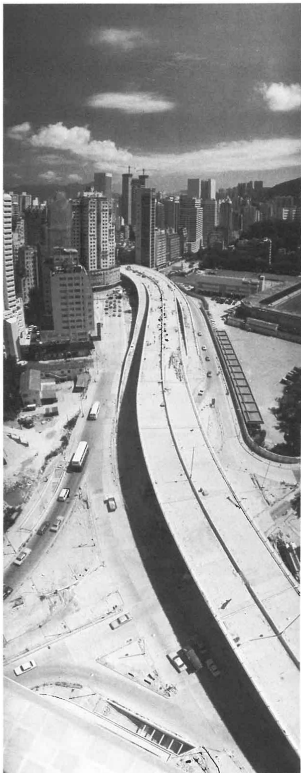
堅拿道天橋建成後，將直接貫通海底隧道與香港仔隧道。
